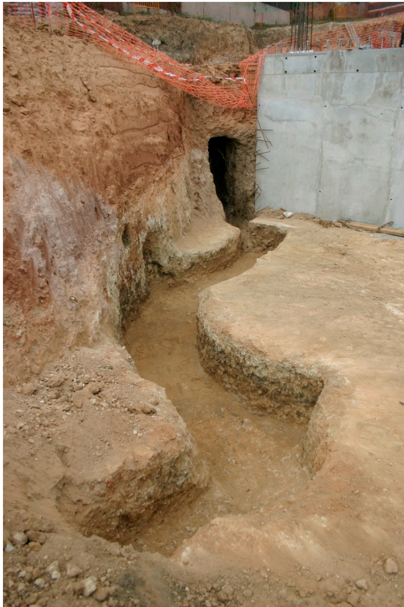
Vista de la continuació de la galeria localitzada a cel obert.
